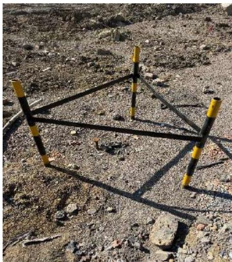
Рисунок 2. Забетонированный твердый репер с ограждением
